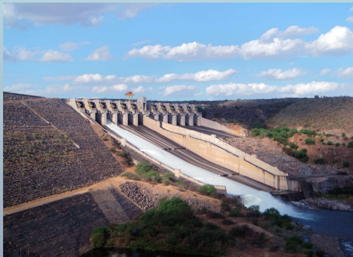
Usina hidrelétrica da CHESF em Sobradinho (BA)
