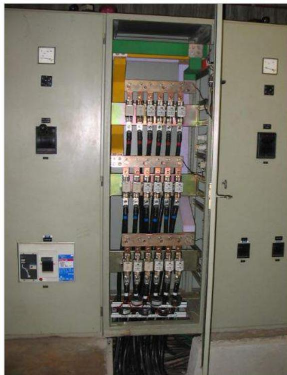
**Figura 5 - Instalação dos TC's no cubículo de saída do painel de medição.**
