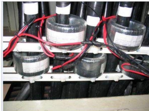
**Figura 4 - Detalhe da instalação dos TC's. Em cada cabo foi instalado um TC e os secundários foram conectados em série.**
