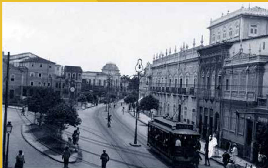
Sede do IPB e da Escola Politécnica, antes da abertura da Avenida 7 de Setembro
