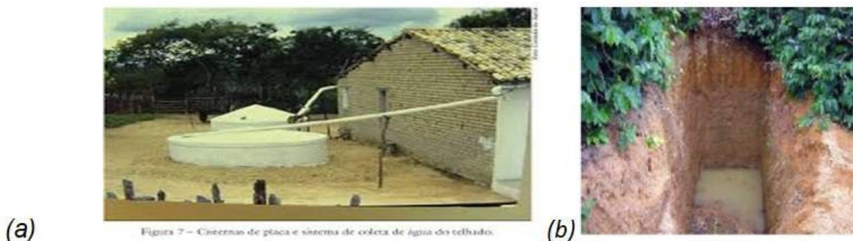
**Figura 9 – Tipos de Captação de Águas: (a) em telhados; (b) caixas secas**
